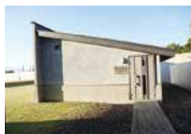
新設した収蔵庫
